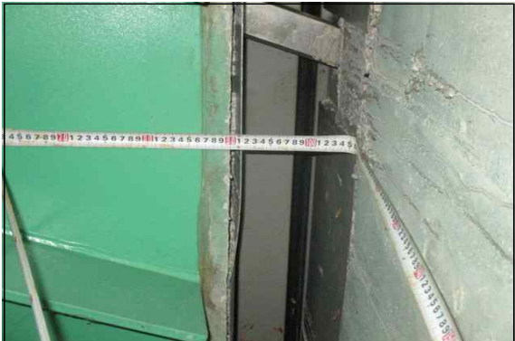
신축이음 하부 유간측정 현황(A2)
