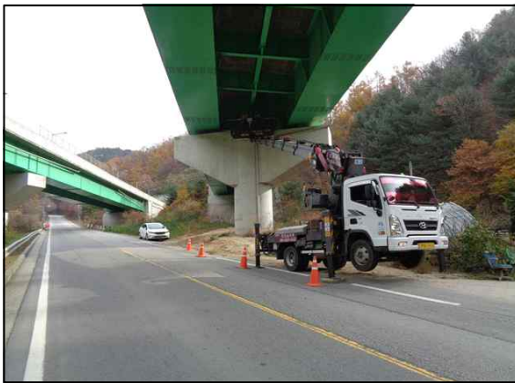
작업차량을 이용한 외관조사
