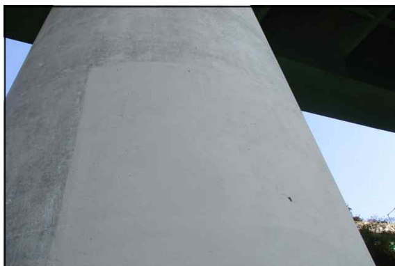
교각 기둥부 균열보수현황(P1)
