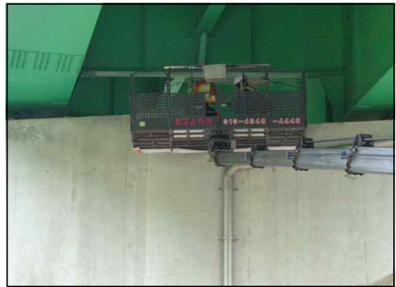
작업차량을 이용한 외관조사
