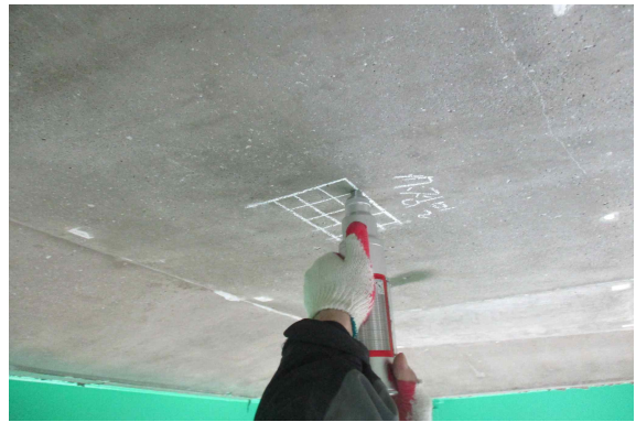
바닥판하면 압축강도 측정②
