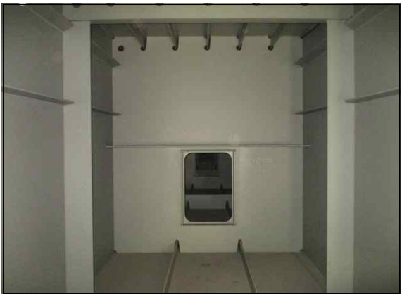
거더 내부 전경
