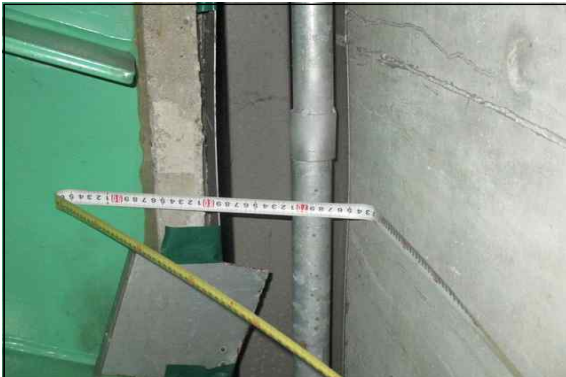
신축이음 하부 유간측정 현황(A1)
