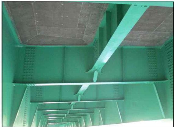
거더 외부 전경
