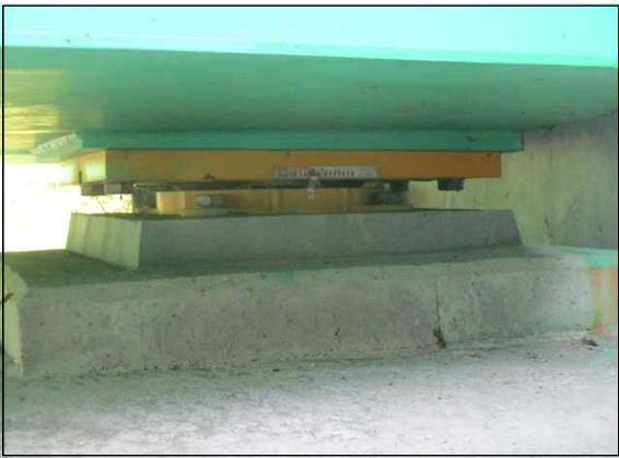
받침 전경(A2 SH2)
